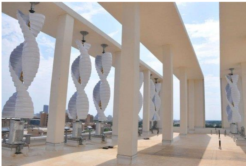
3. ábra – Épületbe integrált szélerőmű az Oklahomai Egészségügyi Kutatóközpont tetején
