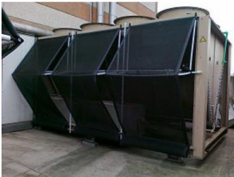
33. ábra – Kompakt léghűtőes gépek adiabatikus nedvesítéssel
