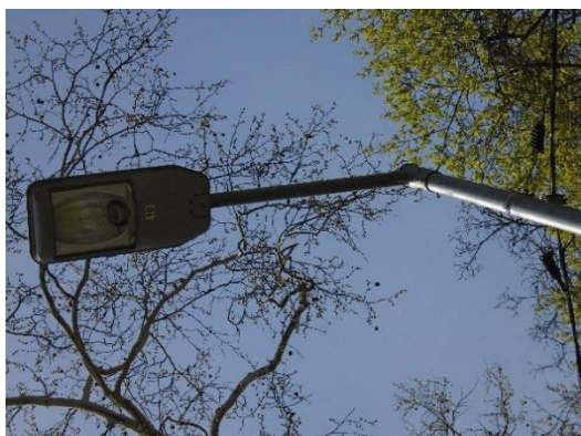
22. ábra Tungsram Schreder gym.-ú; ONYX típ. lámpatest
