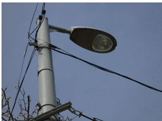
21. ábra Philips gym.-ú SGS típ. lámpatest
