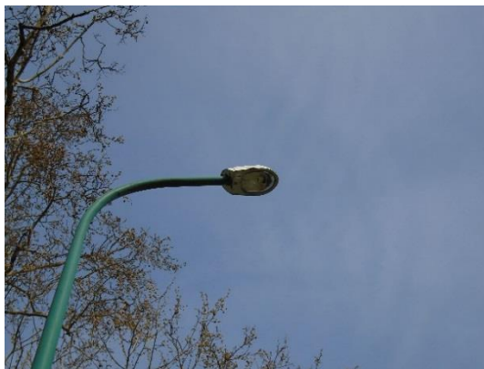
20. ábra Tungsram Schreder gym.-ú; Zafir típ. lámpatest
