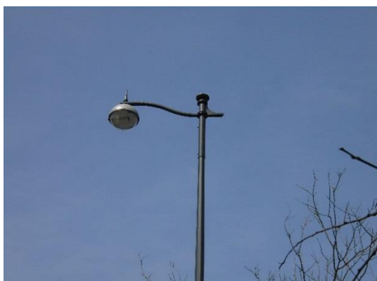
23. ábra Tungsram Schreder gym.-ú; Super Saturn típ. lámpatest
