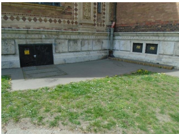
13. ábra Megszüntetésre kerülő 27501/10 tr. állomás a Petőfi Csarnok épülete mellett
